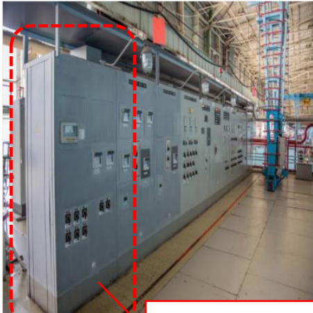
工場内配電盤
